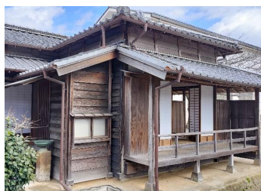
②旧宅・書院外観(中庭より)
